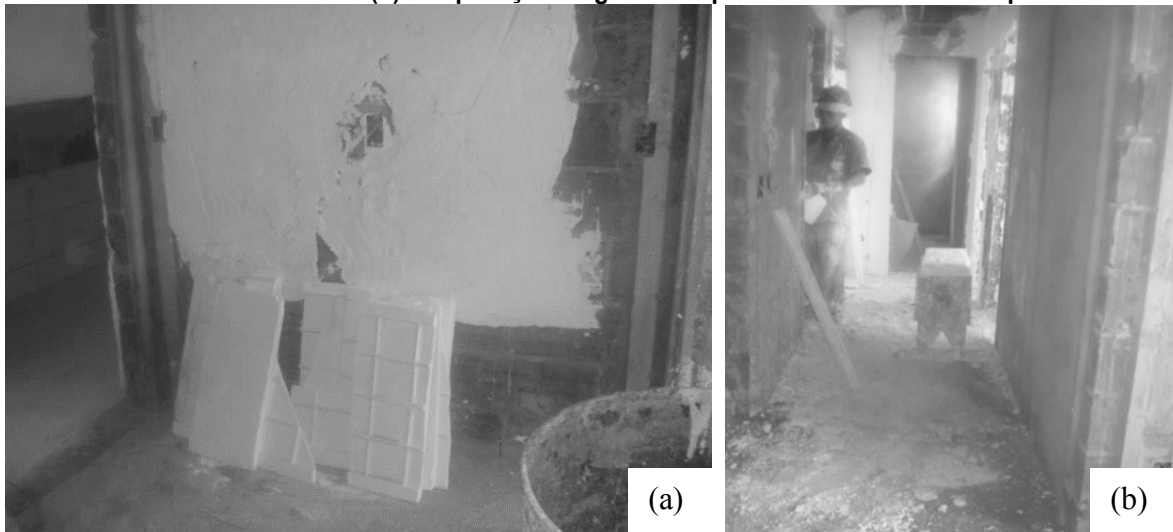
Figura 2 – Exemplos de geração de resíduos de gesso (a) de recorte de placas utilizadas como revestimento de forro e (b) da aplicação do gesso em pasta no revestimento de parede
