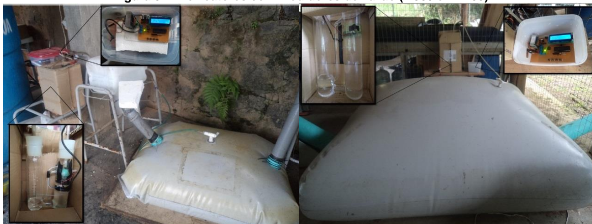
Figura 5 – Biorreatores com medidores de vazão (M500 e M1400)
