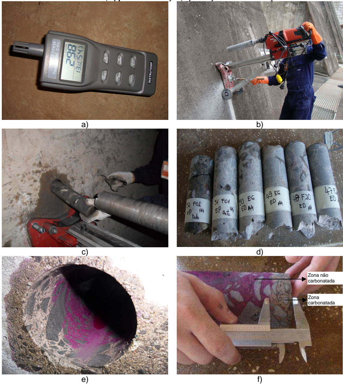
Figura 3 - a) medição do CO 2 ; b e c) extração dos testemunhos; d) testemunhos extraídos e identificados; e) ponto de extração; e) medição da carbonatação.
