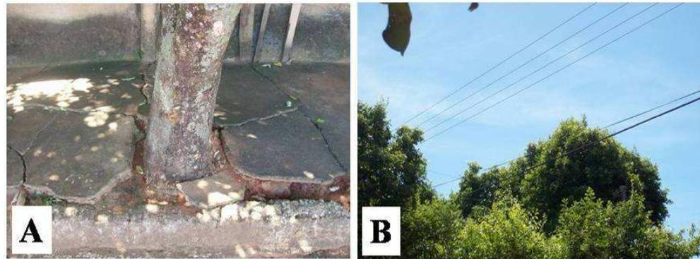
Figura 6 - Imagens de problemas causados pela utilização de espécies vegetais de grande porte. A) No calçamento. B) Para a fiação.
