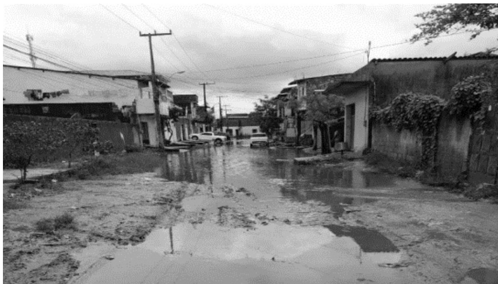
Figura 4 - Ocupações na área de risco de inundações, no bairro Parque das Nações.
