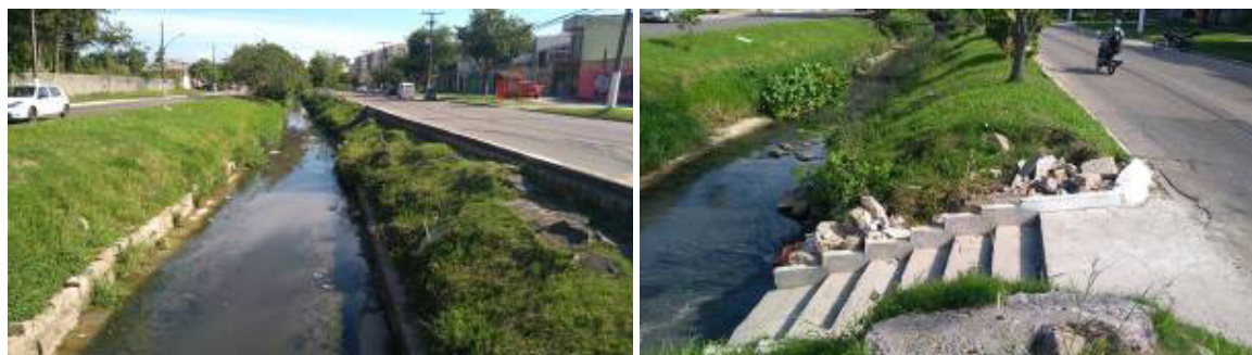
Figura 6. Fotografias de vistas parciais do trecho III (fotografias superiores) e IV (fotografias inferiores) do Canal do Pepino.
