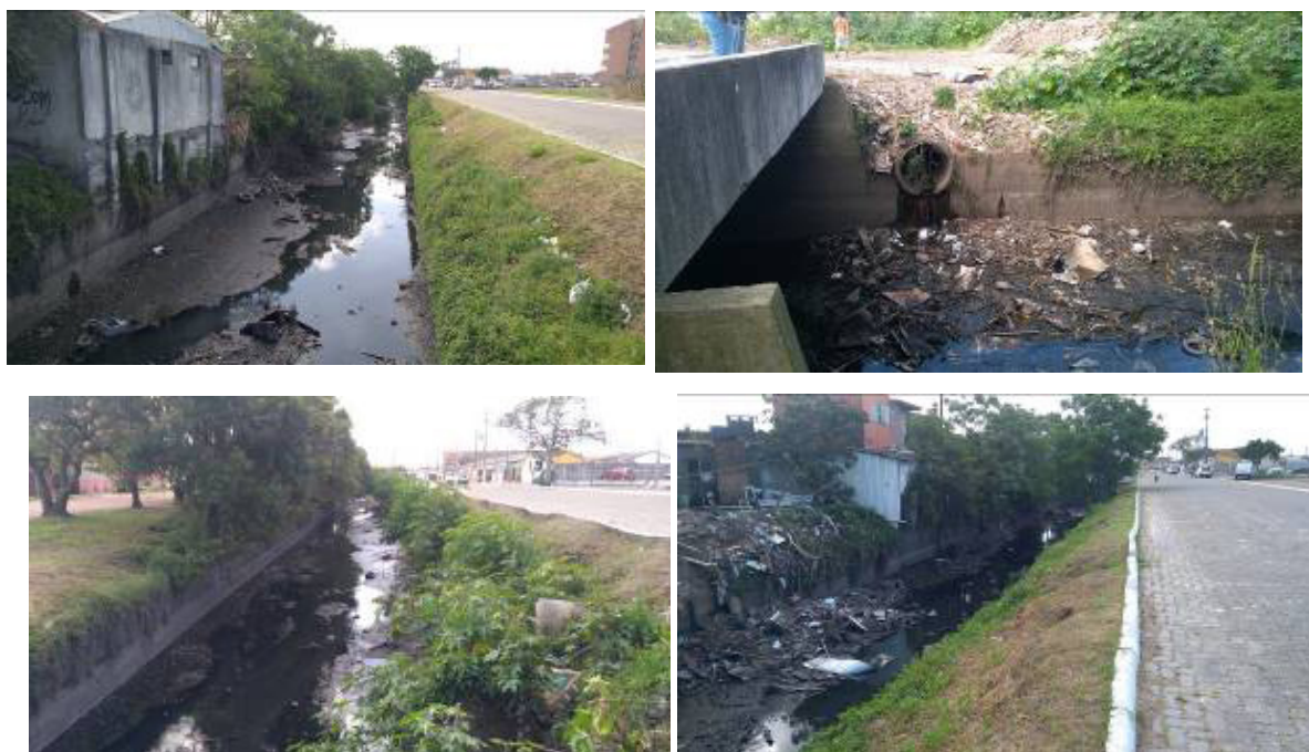
Figura 8. Fotografias de vistas parciais do trecho VII do Canal do Pepino 1 .
