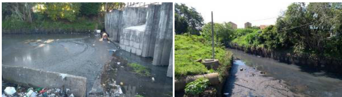
Figura 9. Fotografias de vistas parciais do Canal do Pepino, próximo a Casa de Bombas do Anglo.
