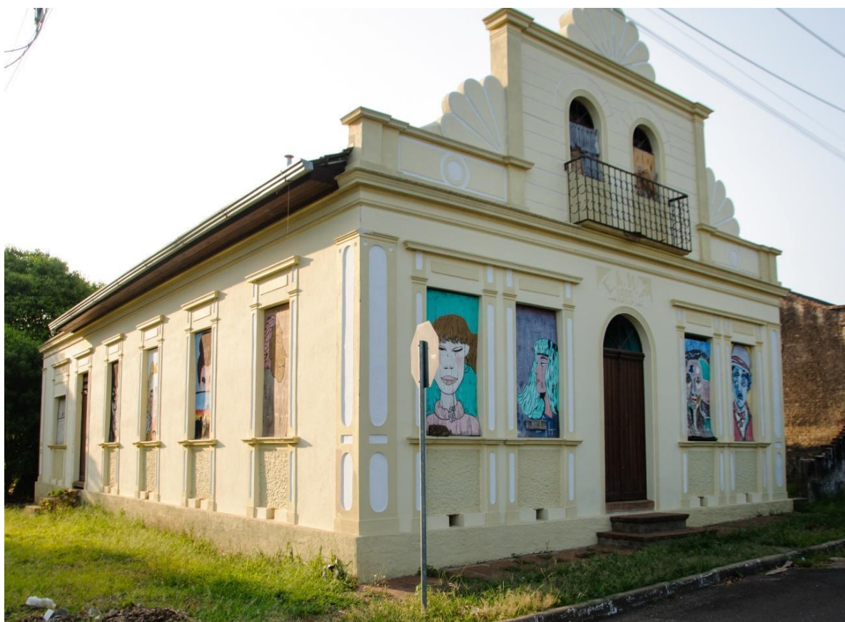
Figura 6 - Casa de Cultura sendo restaurada
