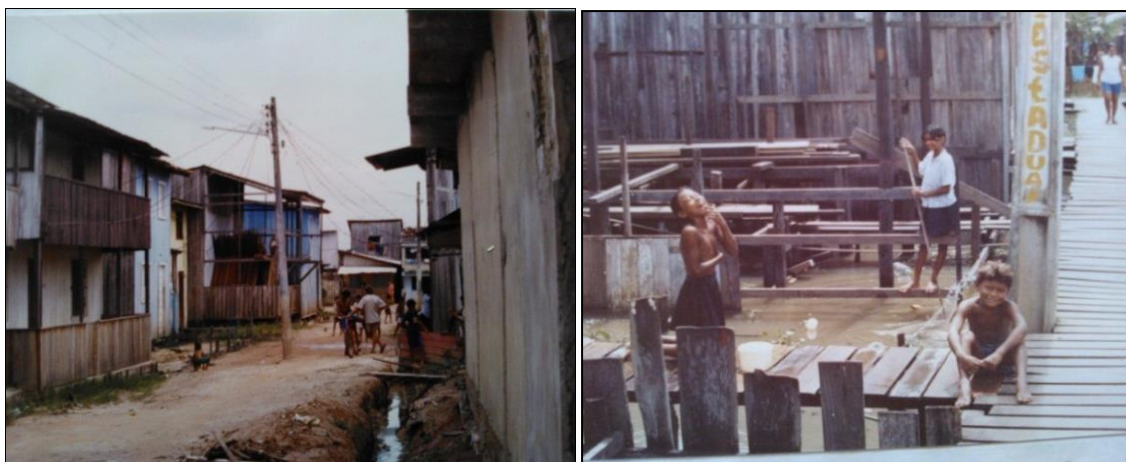
Figura 2 – Rua aterrada pelos próprios moradores e a construção de estivas (pontes de madeira)
