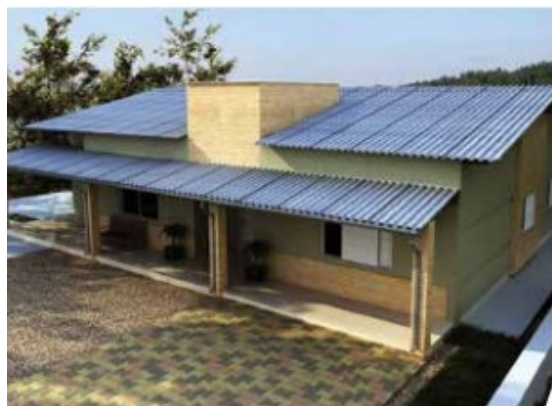
Figura 2: Casa popular com cobertura de telha de fibrocimento
